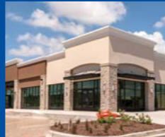
Kommersiella byggnader och flerfamiljshus
