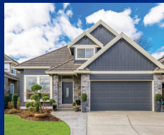
신축 건물 및 재도색
